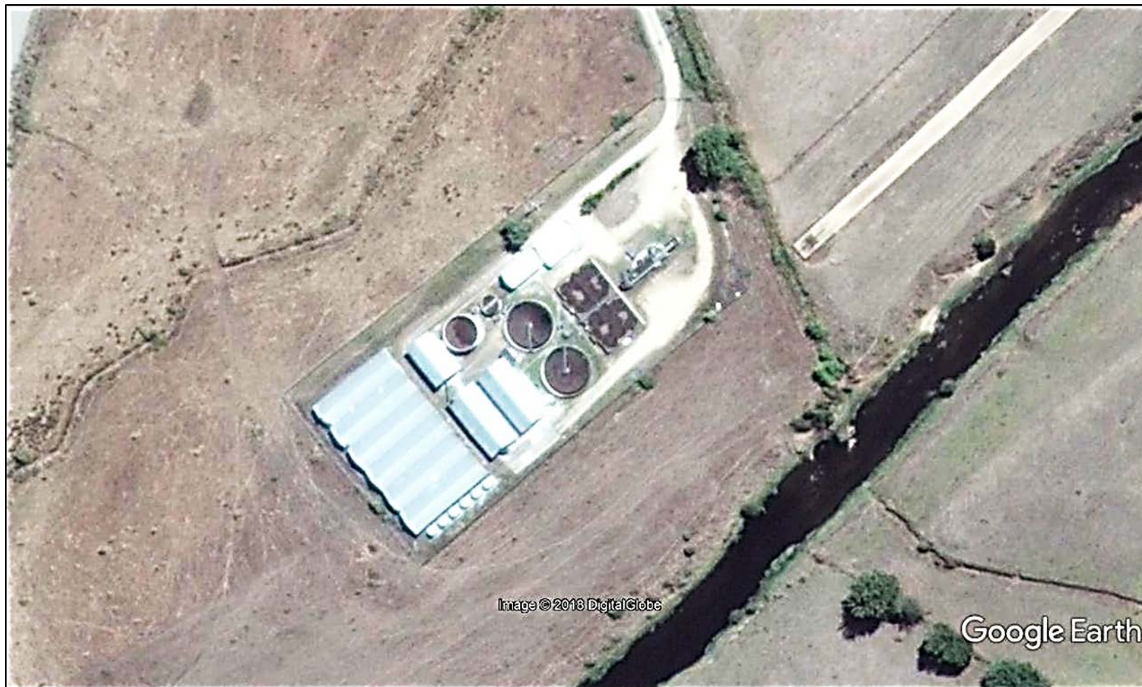
Figura 9. Infraestructura tratamiento de aguas servidas y cuerpo receptor: río Traiguén.
